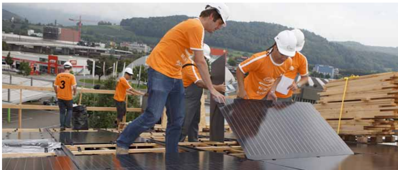
Rund 880 Solarmodule verlegten die Axpo Lernenden im Juli 2011.
