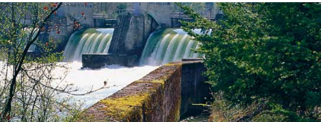
Bild links: Stauwehr, Unterwasserseite mit Fischtreppe. Bild rechts: Querschnitt des Stauwehrs.
