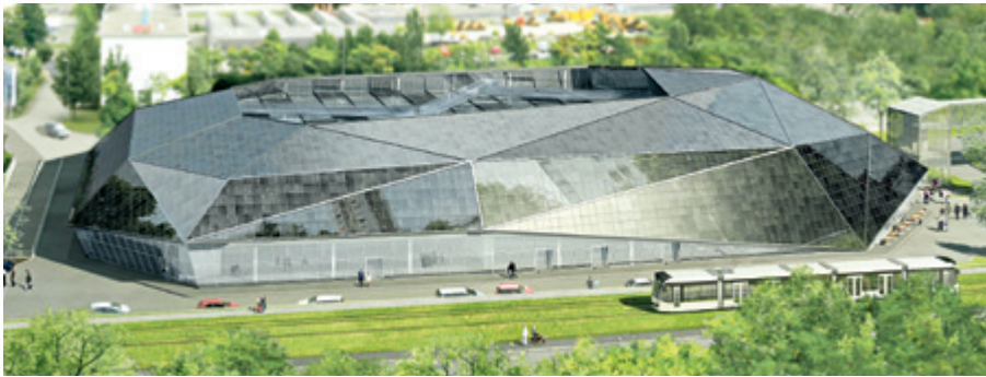
Die zukünftige Umwelt Arena in Spreitenbach. Eindrucksvoll ist das integrierte Solardach.
